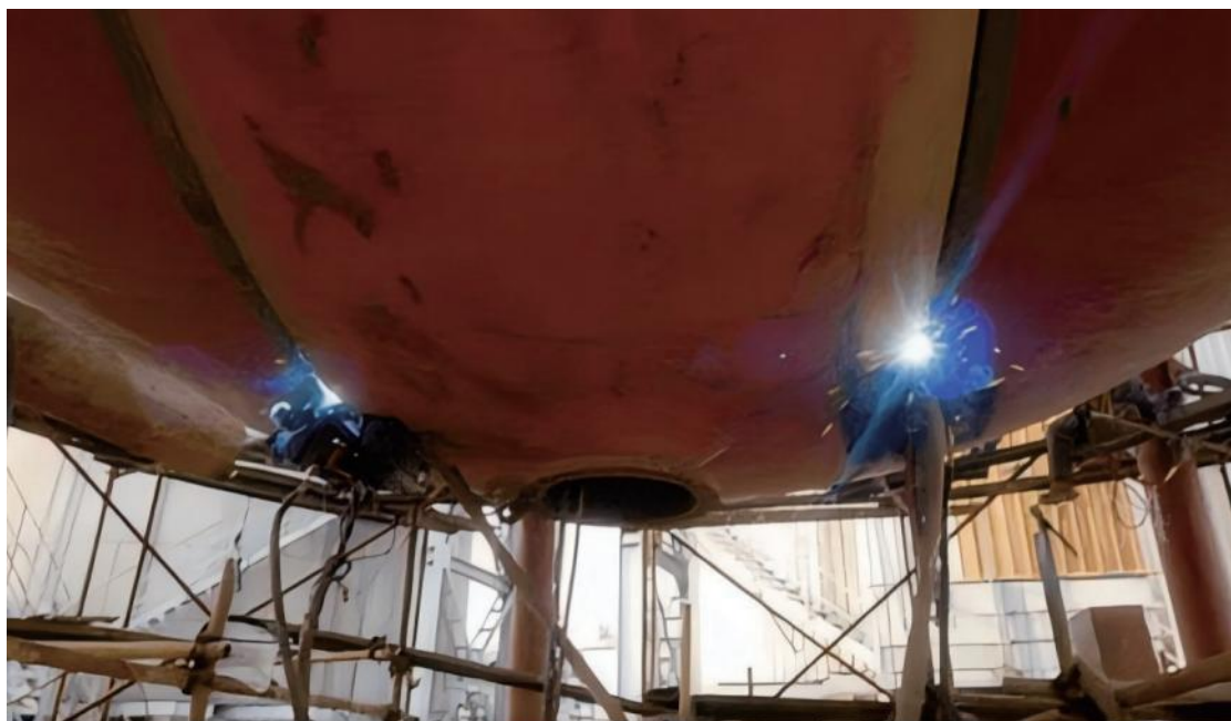
9Ni 钢 LNG 储罐焊接项目 - 江苏 南通 9Ni Steel LNG Tank Welding Project - Nantong, Jiangsu, China
