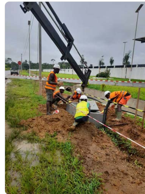
▲ Field Construction work in Côte d'Ivoire
